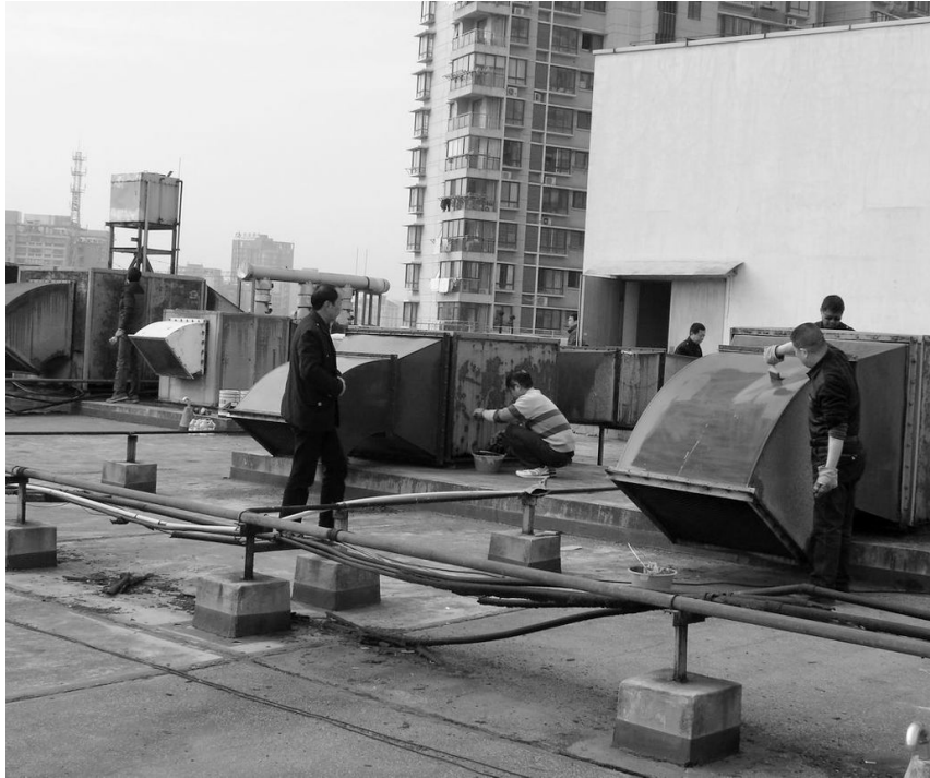
有色置业公司铜冠商业广场积极组织安保及工程人员从四月份开始对楼顶露天安装的消防排烟通风设施设备进行了全面除锈防腐和维护，共维护保养设备 26 台，通风管道 210 余米，节约费用 6 万余元。
