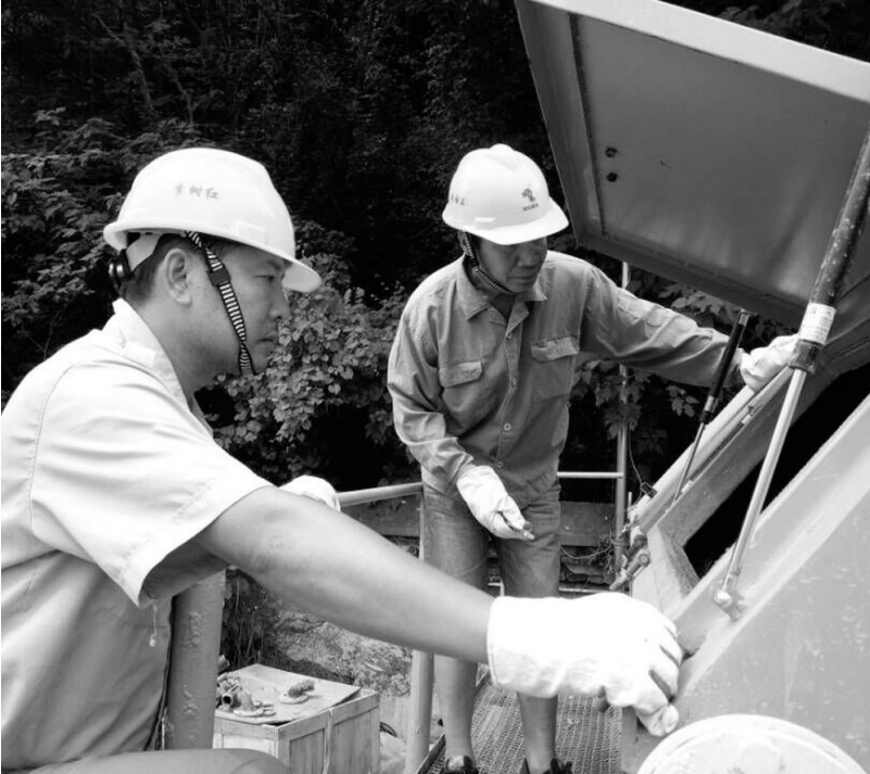
在践行“安全环保、意识先行”活动中，铜冠商品混凝土公司从着眼于保护环境角度出发，近期投资近 14 万元，及时更换一台无法正常运转的砂石分离机。图为工作人员正在调试安装。
