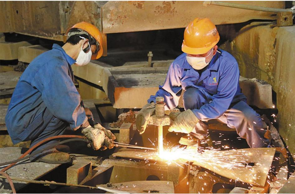
金昌冶炼厂职工日前正在检修阳极板浇铸设备。金昌冶炼厂针对熔炼生产中阳极板浇铸设备老化严重,容易发生故障等现状,在圆盘浇铸机每个班次生产停机后,都要积极做好设备的预检预修,以及润滑、清洁、保养工作,降低了设备故障率,保障了阳极板浇铸生产的稳定。王红平 齐宏明 摄
