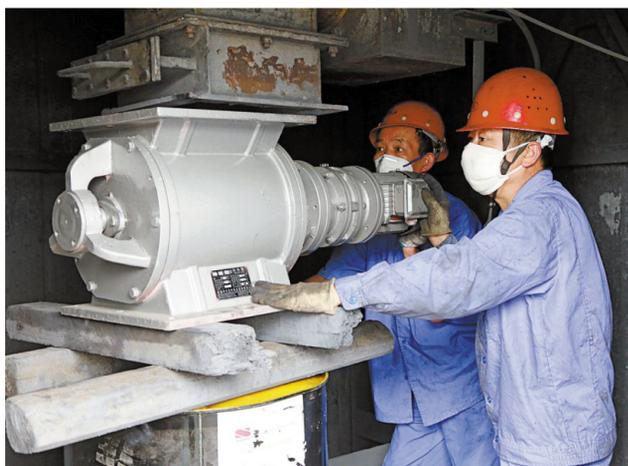
7月8日, 铜冠黄铜公司职工正在更换收尘系统中的卸灰阀。今年以来, 铜冠黄铜公司有计划地推行状态维修和计划维修。并每周根据生产情况, 编写计划维修单, 按照维修单进行逐一计划维修, 上半年, 计划维修达到12次。通过有效管理, 不仅保证了维修、加工质量和工期, 还使得成本明显降低。 王红平 汪勇 摄
