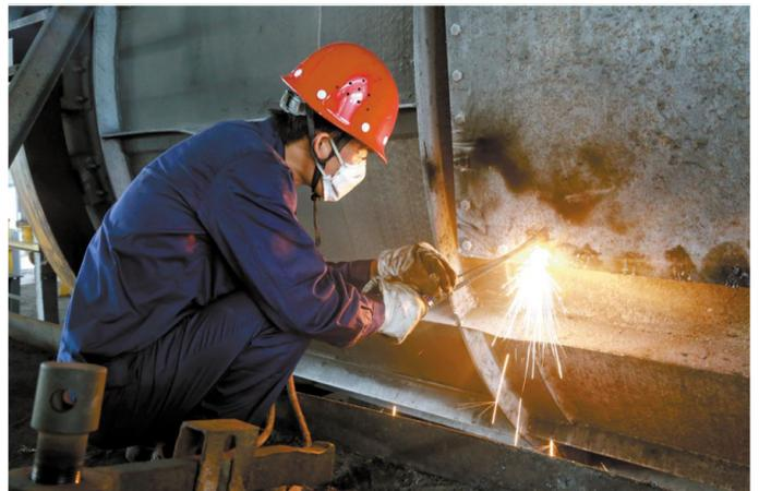
铜冠投资神虹化工公司职工日前正在转炉检修中作业。神虹化工公司为提高铜陵有色冶炼企业硫化钠产品专供能力, 自去年对车间4台生产转炉进行了技术改造以来, 今年前5个月硫化钠产量达1.5万吨, 同比提高了30%。为保证下半年转炉生产稳定, 近日, 该公司借金昌冶炼厂大修, 硫化钠产品需求暂时减少之机, 组织技术力量开始对转炉、风机等进行了年度检修保养。 王红平 陆文武 摄
