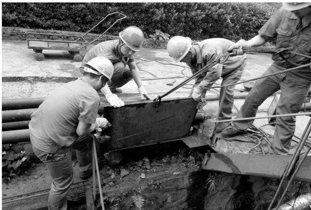
凤凰山矿业公司选矿车间精矿控制室铁制楼梯,因梯口高低不平,存在着安全隐患。这个车间组织电气工段员工配合焊工在梯口处制作平台,并重新焊接楼梯,及时消除了这一安全隐患。
