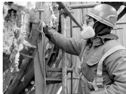
为确保今年雨季球团系统平稳有序生产,铜冠冶化分公司球团车间未雨绸缪,在雨季来临之前组织岗位操作工和设备点检员认真检查往年雨季季节系统设备故障多发点,对查出的隐患立即落实整改,精心组织、安排计划性维修,取得了较好效果。图为检修人员正在检修球团系统主电除尘出尘口烟道漏点。朱长华 李文波 摄
