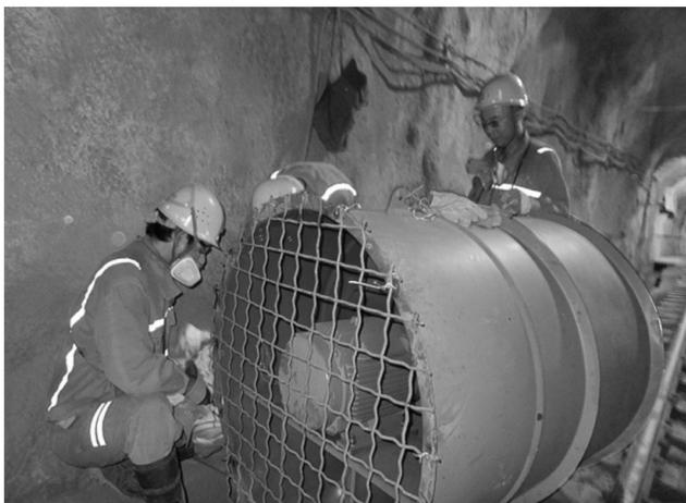
进入夏季以来,冬瓜山铜矿根据深井开采的特点,针对该矿矿石含硫较高,井下作业场所温度过高,机械回风不畅的现状,加大机械通风工作力度,安装大功率通风机设施,改善职工工作环境。图为该矿井下工作人员正加紧在运输区负875米46线安装更换XHL-7.5kw轴流式风机场景。左勇 王文怀 摄
