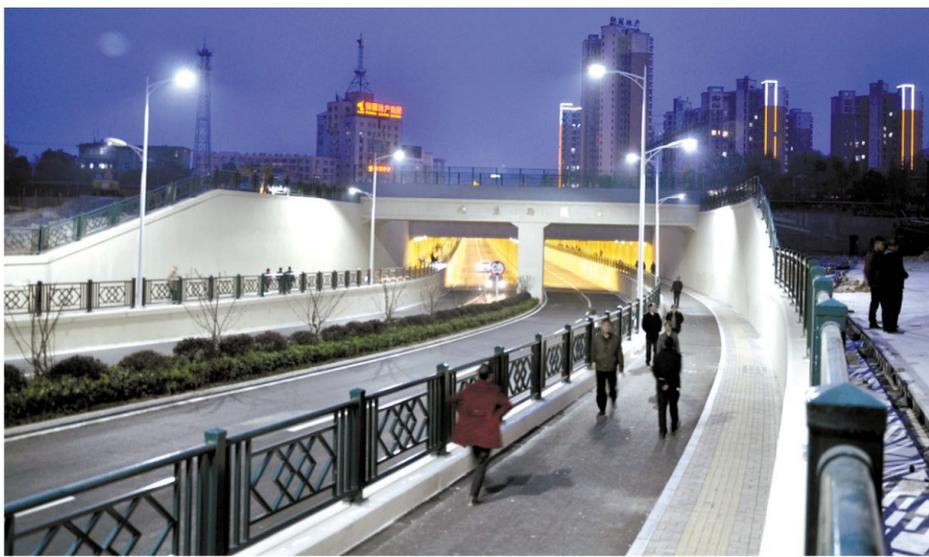
日前,北京西路下穿工程竣工通车。这项工程全长763米,东起天津路,西止北京西路延伸段,自东向西依次下穿铜官大道、老火车站广场、站房、17股铁道等,然后与北京西路延伸段连接。下穿段全长571米,人行道宽2.5米,非机动车道宽1.5米,机动车道宽16米。这项工程的通车,改善了该地区的交通环境。图为下穿工程西段入口。张明亮 摄
