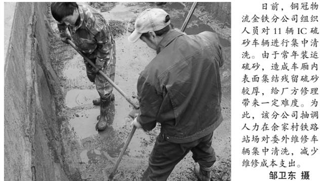
日前,铜冠物流铁分公司组织人员对11辆IC硫磺车进行集中清洗。由于常年装运硫磺,造成车厢内表面集积残留硫磺较厚,给方修理带来一定难度。为此,该分公司抽调人力在余家村铁路站场对委外维修车辆集中清洗,减少维修成本支出。
