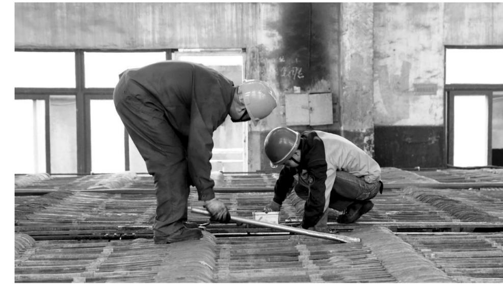
金昌冶炼厂电解车间内外协维修人员日前在维修整流板。为保证电解生产的稳定,该厂加大了电解生产系统及设备的日常维护与保养,适时利用出铜暂停间隙,安排外协维修人员对槽面发现故障的设备及时开展抢修,确保了电解生产设备的平稳运行。
