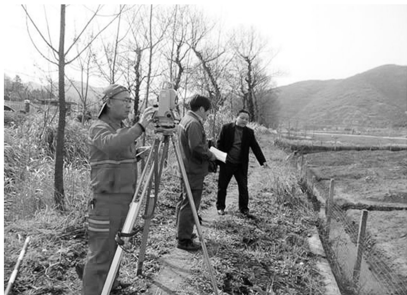
为保证测量数据准确详实,日前,矿产资源中心测绘院测量人员前往凤凰山进行野外测量过程检查。 图为测量人员正在用全站仪采集凤矿地形测量数据。 傅大伟 陆红霞 摄
