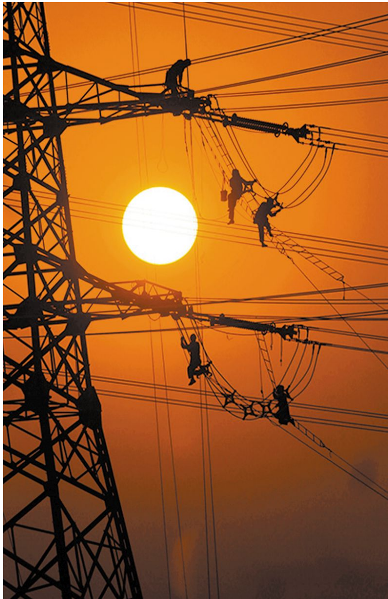
智能变电站配套线路改造。
