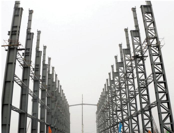
日前,随着铜冠(庐江)矿业公司磨浮主厂房主跨钢架被吊车一捆捆地缓缓吊起,厂房正式进入到主跨吊装阶段。该厂房包含两个主跨和一个附跨,跨度分别为27米、24米和15米,主跨钢柱檐口高度分别为30米、23米,附跨钢柱高度为13.5米,建筑面积近万平方米,预计全部16根钢架吊装将在3月内完成。图为该公司磨浮主厂房施工现场。 王树辰 摄
