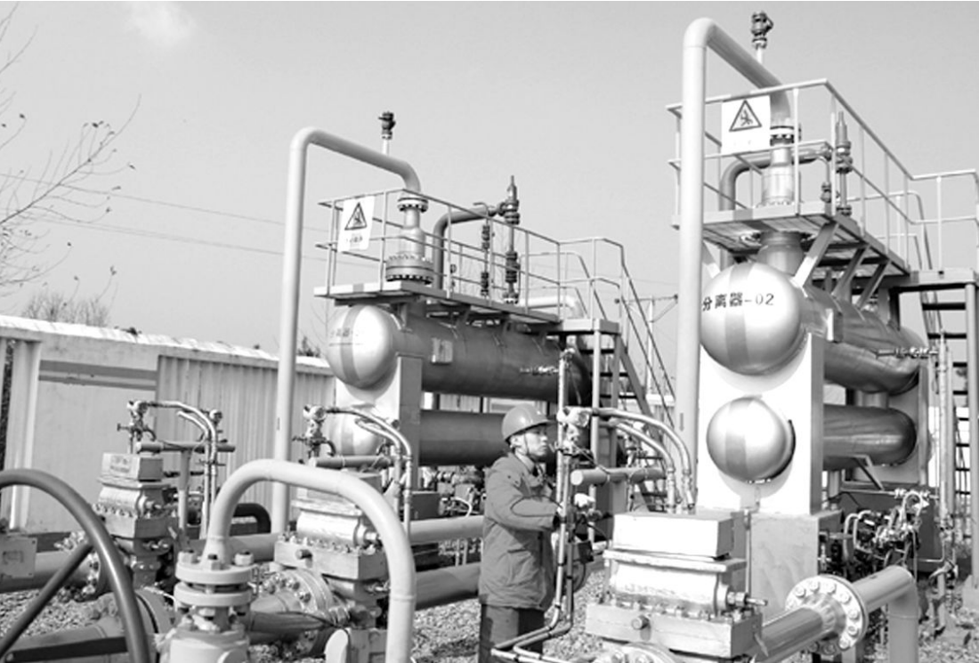
西南油气田川中油气矿建立输配气预警系统, 截至 1 月 25 日, 该矿管辖的阆中工业园区站至双龙配气站输气管道日输气量从 20 万立方米上调至 60 万立方米后, 已安全平稳运行 50 天。图为员工巡检。
