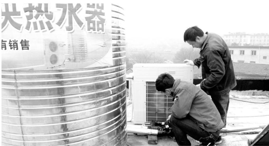
铜冠物流公司十分重视职工的合理化建议,千方百计为职工解决实际困难。困扰铁路一线职工多年的“洗澡难”问题一直是职工反映最热点的问题之一,为此,该公司通过积极争取政策和资金选购了两台大功率空气源热水器,分别安装在金铁分公司所属的车务段和机务段供一线行车人员使用,满足了职工的需求。图为近日厂方工作人员正在车务段楼顶安装空气源热水器。
