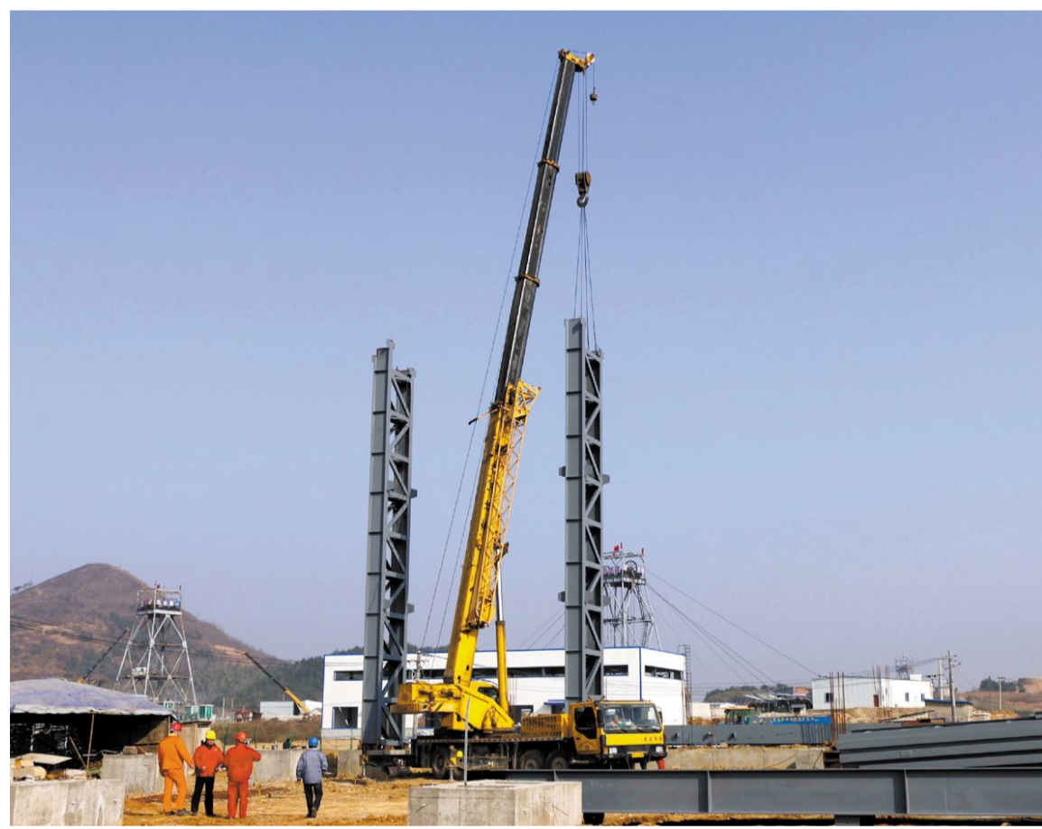
日前,铜冠(庐江)矿业公司选矿车间主厂房建设已全面进入到钢柱吊装阶段(如图)。据了解,该公司选矿车间磨浮厂房为钢架结构,局部钢平台,厂房高度最高31.5米,共有48根钢柱,柱距9米。目前已竖立14根钢柱,随后还将有34根高十余米的钢柱依次立起。 王树辰 摄
