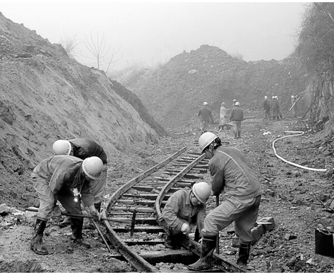
日前,凤凰山矿业公司工程车间施工员工正在铺设运输轨道、安装卸矿架头设备,向施工节点目标发起冲刺,保证+140米废石运卸系统施工进度,早日形成生产能力。图为施工人员在铺设运输轨道。 王松林 段青 摄
