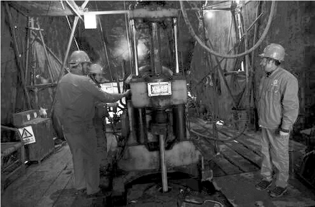
近日,安徽省淮北市矿山集地热资源预可行性勘查项目正式开钻,这也是该市历史上勘查的第一眼地热井。该项目预期可以找到较好的中低温裂隙型地热资源,为资源枯竭型城市经济发展增添新的增长点。
