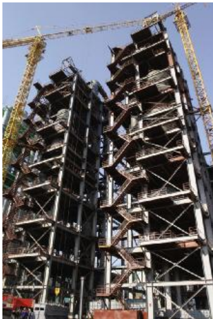
▼焙烧钢体结构完成,正在进行主体设备安装。
