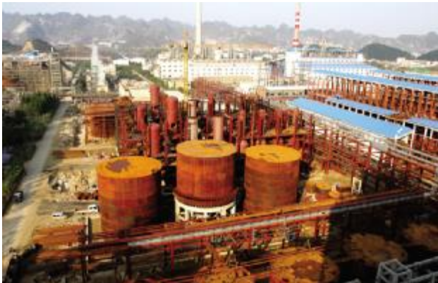
▲蒸发系统设备安装全部完成,四月下旬进入单级试车。
