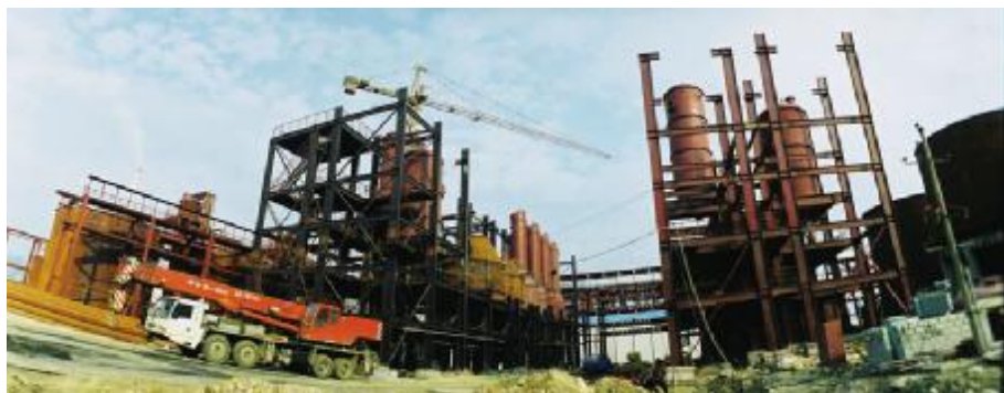
▲蒸发系统正在抓紧组织现场施工和设备安装。
