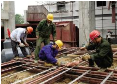
▲分解片区进入交工验收阶段。图为工人在分解槽上粉刷防腐油漆。
