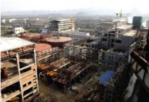
▲沉降厂房主体结构和土建工程完工,4月进入试水调试阶段,5月下旬联动试车。
