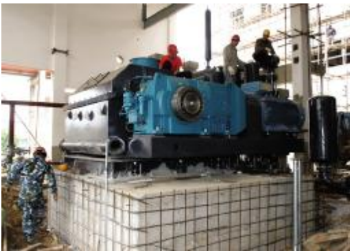
▲工人在抓紧时间安装调试溶出高压泵房隔膜泵。
