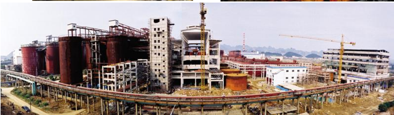
▲蒸发系统设备安装全部完成,四月下旬进入单级试车。
