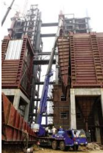
▲安装工人在吊装焙烧电收尘组组件。
