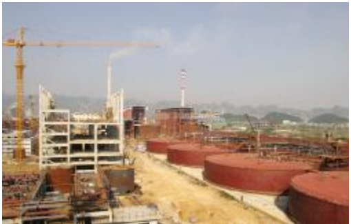
▲由中国六冶公司承建的氧化铝三期工程赤泥沉降分离及洗涤、种子过滤、赤泥过滤等子项工程进展顺利。图为沉降系统工程建设场景。(唐宏升/文 马雁飞/图)
