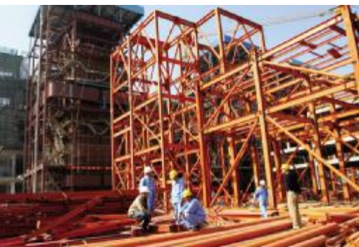
▲图为三期热电厂厂房主体结构施工场面。(白泉摄)
