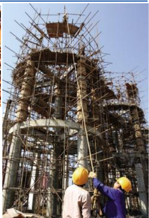
▲图为氧化铝三期高压溶出建设工地施工现场。(白泉 摄)
