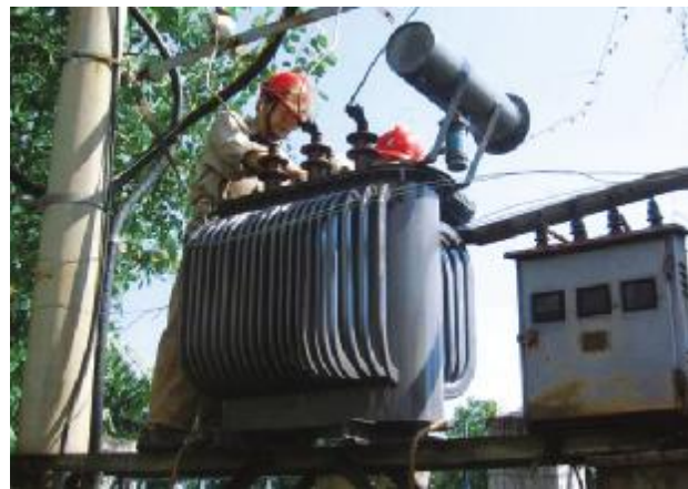
检修人员在拆卸变压器。 黄卫星 摄
