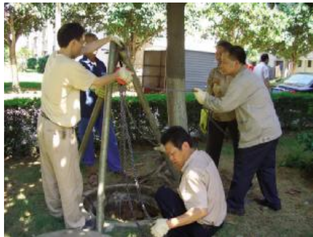
覃海军(右一)和班组成员在疏通污水道。
