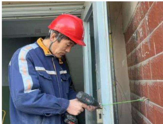
为解决居民楼门回弹过快、关闭不严等问题,近日,后勤保障中心组织人员为所辖小区安装楼门防护绳。施工人员克服天气寒冷、人员少等困难,精心设计施工,截至目前,已安装楼门防护绳千余条。此举既降低了居民楼门的安全隐患,也让住户感受到贴心的服务和贴心的关怀。图为该中心员工正在安装防护绳。摄影报道 张姣 文亚彤
