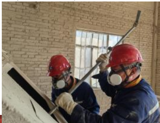
石灰石矿事业部:无惧困难,奋力疏通料口。
