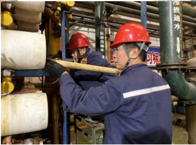
热电分厂:加班加点,更换反渗透膜。
