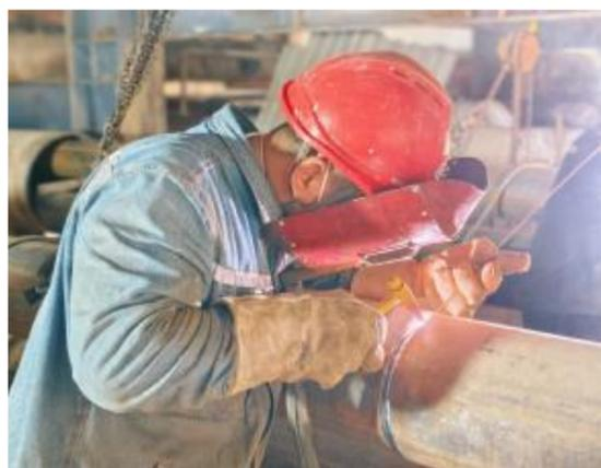
为消除氧化铝厂高压溶出5系列7级三套管安全隐患,提高溶出效率,近日,山西中铝工服根据生产安排和年度设备检修计划,组织实施大修。此次大修要更换三套管600余米,由压容车间、水力清洗单元、起重吊运车间、工业清理车间、设备安装检修车间共同承担任务,5家单位密切配合,加班加点,协同作业,目前,三套管内管穿管任务已过半,所有大修任务正有序推进中。图为焊工正在焊接内管。 摄影报道 郭美霞
