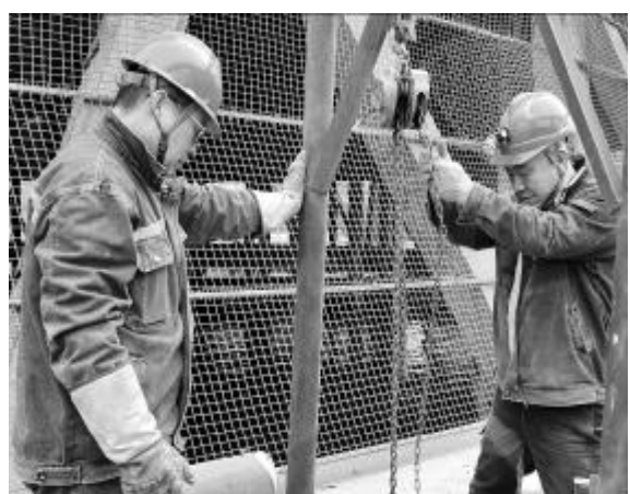
2月28日,山西中铝工服热动设备维修车间通过精心组织,完成了热电分厂浓盐水排送管道改造任务。接到任务后,该车间提前查看现场,准备施工设备。在施工过程中,为了确保管线坡度符合改造要求,钳工、焊工通力配合,仔细测算、焊接管道支撑架。经过两天半的奋战,完成了近100米管道的敷设、焊接、合叉及加装阀门改造任务。图为施工人员正在吊装设备。摄影报道 张瑞 张建峰
