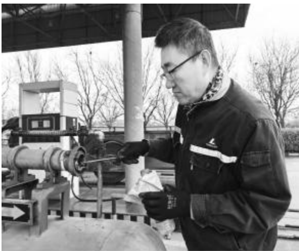
为保证加油站设备安全,近日,营销中心对安全隐患开展全方位排查维检。岗位员工更换了部分消防水带,润滑保养快速接头,及时配备手摇抽油器,确保安全快速完成车辆加油工作。图为加油站员工对泡沫灭火装置进行清扫维护。摄影报道 李娜
