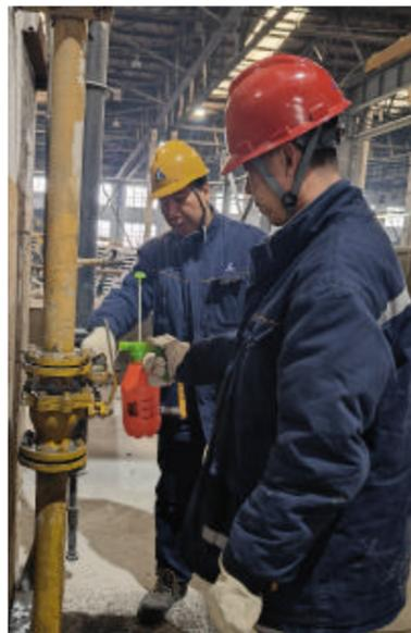
近日,铝加工事业部对天然气系统开展专项检查。主要检查天然气阀门、管道情况,并用测漏仪对天然气设施进行安全监测,排查了燃气管道泄漏点,及时处理了一处安全隐患,检查人员还在现场向岗位员工提问天然气操作的相关问题,提升了员工的安全意识,为安全生产提供保障。图为检查人员在用测漏仪检测管道。摄影报道 卢俊彤
