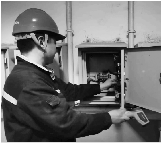
近日,资源综合利用分公司对易发生火灾事故的电气设备开展安全隐患大排查,并对照列出的 17 项清单进行整改,彻底消除火灾隐患;持续开展安全培训,增强员工安全意识和能力,守牢安全底线,确保生产安全稳定。图为电气管理员正在检查原料磨现场控制箱内部状况。
