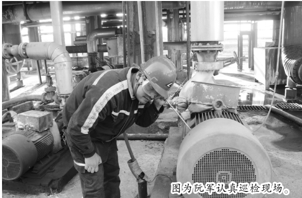
图为阮军认真巡检现场。
