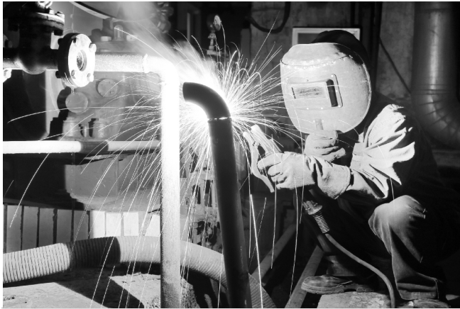
近日,热电分厂汽机工区对除氧器 8 米平台疏水管和冷油器退水管改造合并,既解决了现场疏水通过地面缝隙流到配电室的安全隐患,又改善了现场环境。图为检修人员正在焊接管线。
