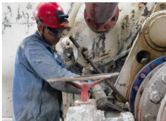
近日,资源综合利用分公司分解工区利用中压脱硅系列切换消缺之机,对种分分解和立盘过滤系统生产薄弱环节进行计划消缺。主要为种分槽分料箱及溜槽、立盘精液分料箱等部位清理结疤,更换6号立盘过滤机软接,共完成清理检修项目7项,为后续生产稳定做好了硬件保障。图为员工正在清理结疤。摄影报道 师晓娟 柴菊珍
