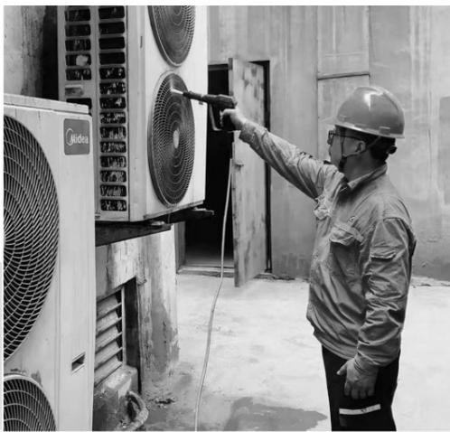
近期,高温天气持续,为确保电气系统正常运行,热电厂电气工区加强对主要设备巡检,发现问题及时处理,确保电气系统设备设施安全稳定运行。右图为员工在为变频空调器测温。 摄影报道 崔丽娜
