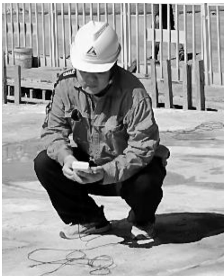
▲山西晋正建设工程项目管理有限公司工程监理员对赤峰氧化铝项目中基础大体积混凝土进行测温。
