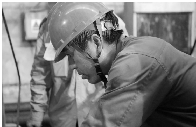
热电分厂员工专注修理给水泵。
