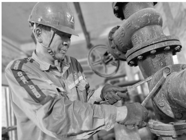
氧化铝厂员工用力紧固回水泵出口螺丝。
