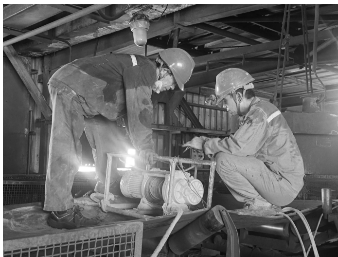
山西中铝工服员工在闷热的皮带廊胶接皮带。
