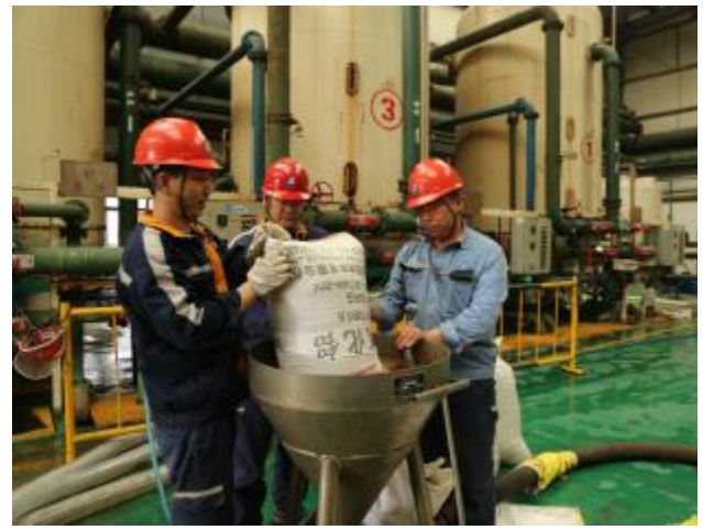
为确保锅炉用水质量,近日,热电分厂燃化工区党支部组织党员干部清理补换罐体树脂。时间紧,任务重,在清理过程中,党员骨干发挥带头作用,配合默契,加班加点,经过8个小时奋战,共清理补换树脂3吨左右。摄影报道 崔丽娜
