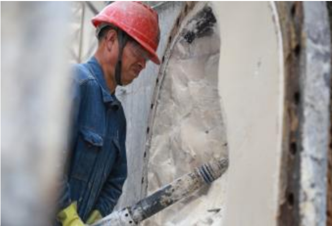
近日,第一氧化铝厂分解工区从设备点巡检和清理维护入手,合理安排计划检修清理消缺,有效消除现场隐患,共检查并处理减速机、出料阀、精种泵等现场设备问题8项,清理种分槽及平面、地沟结疤20余方。图为员工正在清理种分槽入孔结疤。摄影报道 张利 柴菊珍
