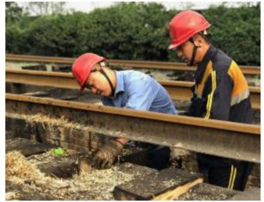
近日,频繁降雨造成机辆段管线20余根枕木出现不同程度的开裂和腐烂,严重影响机车检修和运行安全。物流运输事业部工讯段立即组织员工对腐烂枕木进行更换,并严格按照标准铺设了新枕木,检查确认无质量问题后,7个小时就恢复了通车。图为员工正在更换枕木。
