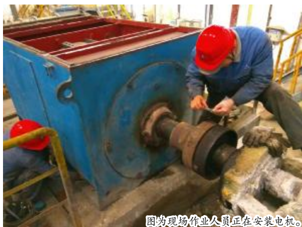
图为现场作业人员正在安装电机。
