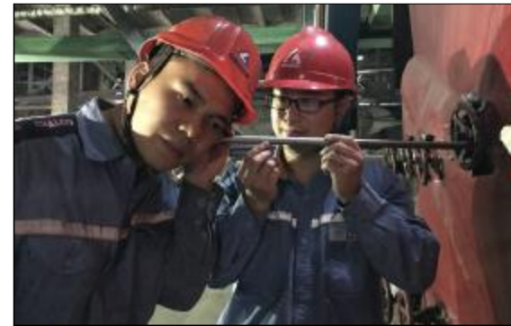
热电分厂锅炉二工区员工王瑞生巧用听针判断异常或内漏阀门,并将方法传授给工区员工,便于及时发现更换内漏阀门,减少锅炉用水隐形浪费。摄影报道 崔丽娜
