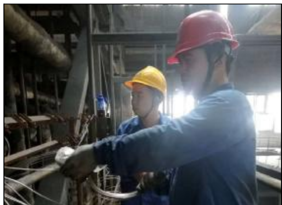
近日,晋铝冶炼自控车间热工一班10名人员,在20米高空平台连续作业6小时,更换6号锅炉壁温元件42个并接线调试,保证锅炉测点精确。摄影报道 任晓华
