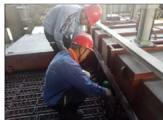
9月11日,电解一厂净化车间组织人员检查电解烟净化除尘系统密封性能,共排查28个除尘器箱体,补焊泄漏点两处,提高了净化效率。图为员工正在检查设备。摄影报道 王致安
