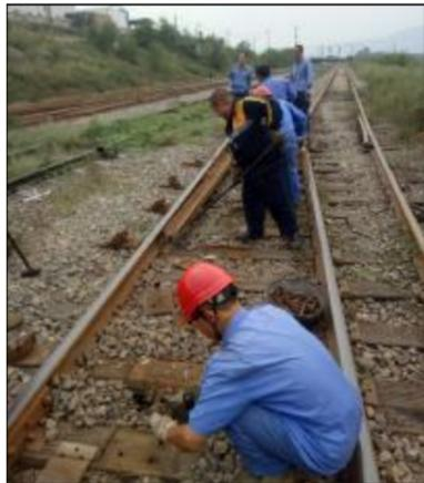
9月11日，针对企业站38#道岔处断轨情况，物流运输事业部工段组织党员突击队赶赴现场进行换轨。经过3个小时奋战，抢修员工完成换轨作业，确保线路安全畅通。图为员工正在更换钢轨。
