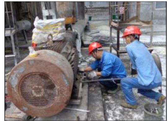
近日,山西中铝工服电气工程分公司机一班克服现场环境狭小、堆积料液多等不利因素,提前两个小时,一次完成第二氧化铝厂两台母液泵电机安装任务。图为电气工程分公司员工正在安装调试电机。摄影报道 郑向京
