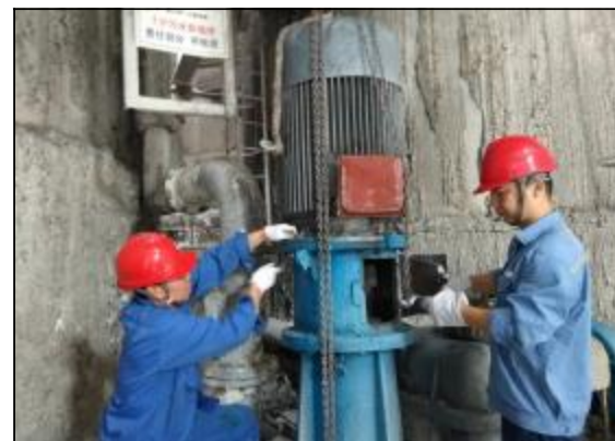
近日,晋铝冶炼公司电气车间组织员工仅用2小时完成了第二氧化铝厂分解一区3号污水泵电机更换任务,保障了种分槽放料、清理等工作顺利进行。图为员工在现场更换电机。
