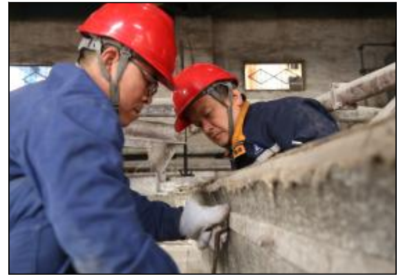
近日,第一氧化铝厂焙烧工区针对设备种类多的实际,采用网格化管理方式,将设备区域细致划分,定人、定点、定区域,确保设备维护、清理工作及时到位。图为员工在清理淋水洗塔系统。摄影报道 张利 暴文平
