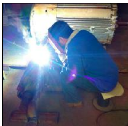
近日,山西中铝工服电气检修工区员工针对转子补焊时需要不停翻转的问题,制作完成了两套电机转子焊接支撑架,减轻了员工劳动强度,节约天车使用时间。摄影报道 郑向京
