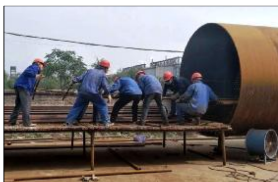
近日,山西中铝工服焊培中心组织人员对第二氧化铝厂蒸发器进行大修,施工人员将1000多根12米长管束穿过9层隔板后完成整体对接,目前加热室管束已全部安装到位。摄影报道 丁庆江
