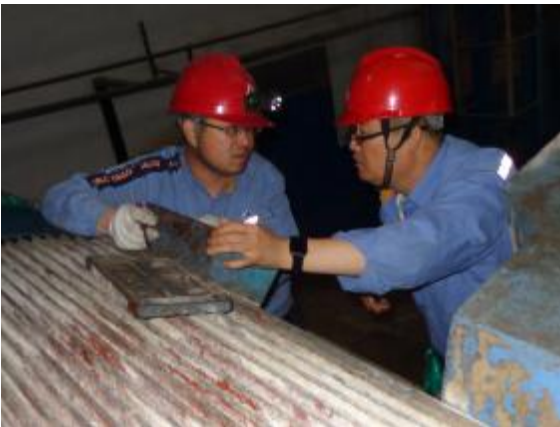
近日,山西中铝工服电气工程分公司组织起重工、天车工、电钳工等工种协同配合,冒雨提前两小时提前完成了喂料泵电机更换任务。图为员工正在安装电机。摄影报道 郑向京
