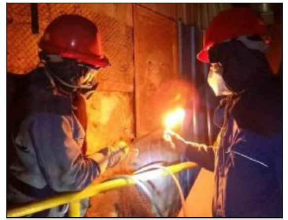
近日，晋铝冶炼公司热动维检中心提前完成 6 号锅炉水冷壁抢修任务。施工过程中，焊工人员精心调整焊枪火焰强度和施割位置；钳工量尺寸、定位置、打坡口，大家分工明确，密切配合，最终经过 30 小时的连续奋战，提前完成了水冷壁的更换任务。摄影报道 王卜瑞 陈文都
