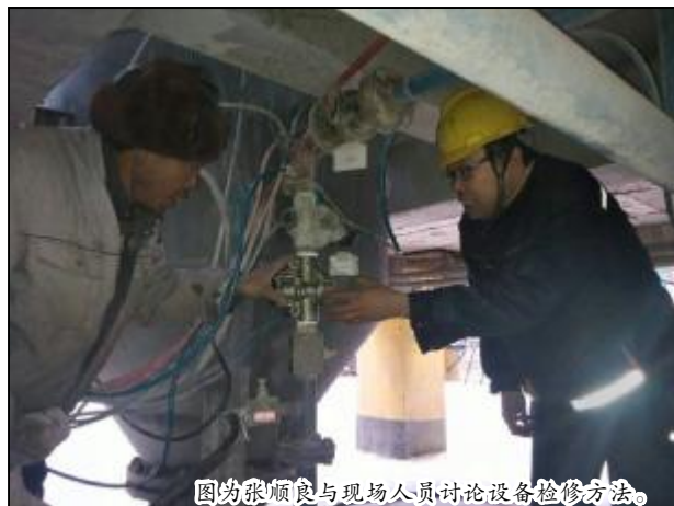
图为张顺良与现场人员讨论设备检修方法。
