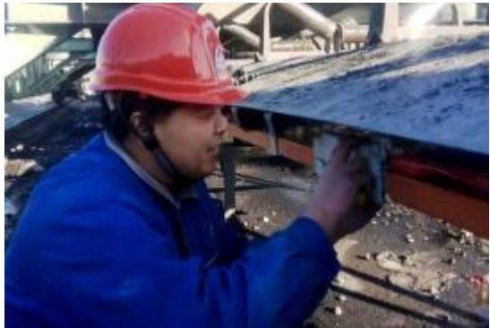
近日,晋铝冶炼电气车间第一作业区对第一氧化铝厂原料车间取料机进行大修,将滑线从地坑移到皮带侧方,更换滑线 1000 余米,解决了滑线、继电器等部件频繁损坏的问题,消除了安全隐患。摄影报道 侯云云
