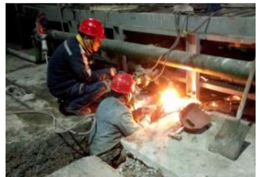
近日,华泽建安公司承担了铸造厂普铝工区9公斤合金锭2号铸机线位移动改造项目。为高质高效完成项目,作业人员实施“一对一”的现场安全作业监督,加班加点对合金锭冷却水上水管进行精准焊接。摄影报道 吴海英
