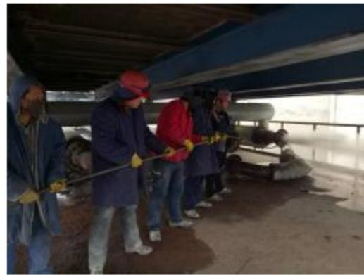
1月6日,山西中铝工服公司专业清理队组织党员骨干对第二氧化铝五系列单套管进行高压水力清理,从拆装套管弯头到高压清洗,有针对性的用超高压喷头反复清洗,管壁除垢率达到 90% 左右,减少了以往因碱洗单套管造成焊缝泄露补焊带来的困难。此次共清理单套管线 200 米,圆满完成清洗任务。图为清洗人员正在对单套管进行清洗。摄影报道 丁庆江
