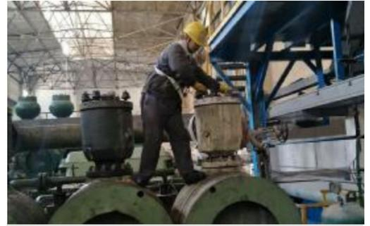
12月25日,第二氧化铝厂溶出工区一喂料泵故障停车,接到任务后,山西中铝工服检修施工处二班组织人员,严格按照标准操作,共拆除、更换阀门6套,更换4套,降低了检修费用,保障了生产正常运行。摄影报道 丁庆江
