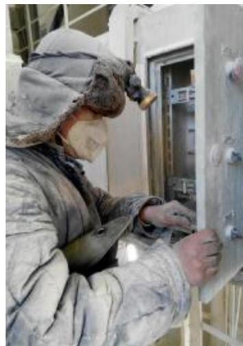
近日,晋铝冶炼电气车间组织员工对第二氧化铝厂脱硫制粉系统仓泵阀门进行检修,参与员工在大粉尘、高噪音的环境中,对控制箱进行吹灰、检查,仅用1小时排除故障。摄影报道 范士财 侯云云
