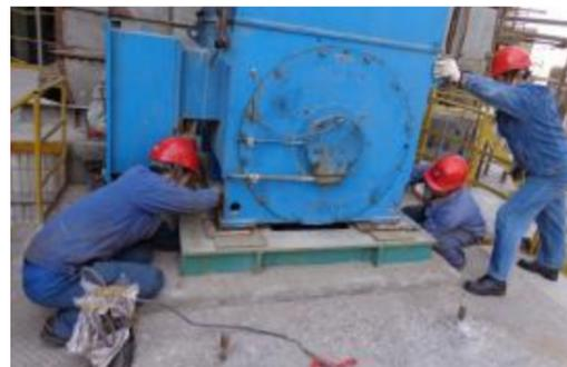
12月12日，经过14个小时连续奋战，山西中铝工服检修施工处顺利完成了氧化铝二厂高压溶出喂料泵PD107电机检修任务，一次试车成功，保证了设备按计划投入生产使用。
