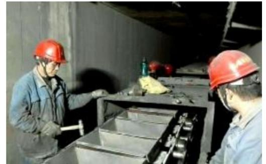
近日,晋铝冶炼检修三车间炉检三班组织员工对热电分厂新系统2号输渣机隐患进行处置,检修员工连续作业7个小时,拆装料斗,共更换托辊38个,有效解决了输渣机漏渣、转动时高低起伏等问题。图为员工正在更换托辊。摄影报道 占耀文 闫晋兵
