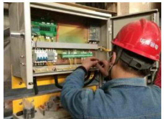
近日,经过10余天的规范安装及性能调试,中铝山西新材料有限公司电解一厂智能打壳系统设备顺利完工并投入使用,改造的四台电解槽基本实现单点打壳及堵料自动打壳功能。摄影报道 徐小五 原香梅
