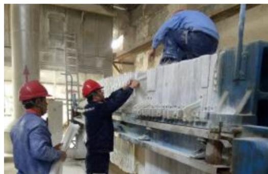
近日,精细氧化铝公司干法工区利用2号胶带机大修期间,同步对1、2号烘干系统的主机进行维护消缺,更换板框滤布,保障稳产高产。摄影报道 王丹
