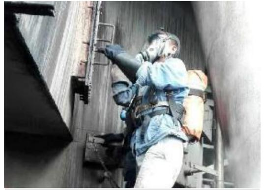
近日,晋铝冶炼公司煤化工项目部顺利完成重庆群邦煤气站2号炉抢修任务。接到任务后,煤化工项目部迅速制定方案,采取有效安全措施,在防护人员监护下,组织作业人员佩戴空气呼吸器带气抢修煤气泄漏点,更换人孔和阀门密封材料,连续奋战数小时顺利完成抢修任务。
