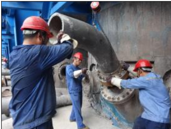
近日, 第二氧化铝厂溶出二区对溶出 V 系列闪蒸槽过料管进行更换。此次更换, 用加了耐磨层的双层耐磨管替换原单层管, 解决了原单层过料管漏泄和安全隐患, 确保设备实现长周期、安全稳定运行。 摄影报道 赵君 张娜
