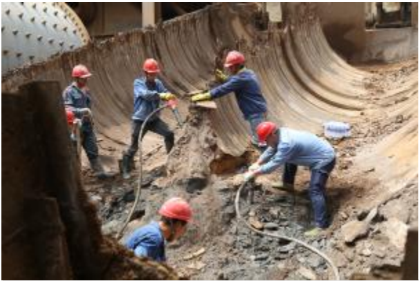
近日, 第一氧化铝厂按照计划部署, 对 9 号溶出磨展开大规模检修清理行动, 清除结疤, 消除设备隐患, 为氧化铝烧结法提产降耗提供有力保障。摄影报道 张利
