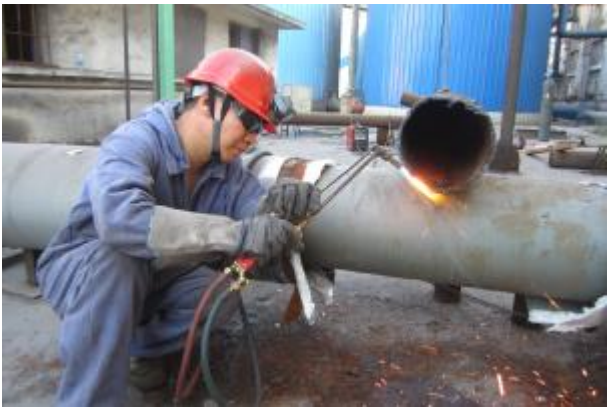
近日, 晋铝冶炼检修三车间利用热电分厂老系统停水间隙, 组织 20 多人分四组连续作业 12 个小时, 对冷油器冷却外排水进行并线改造, 优化流程, 实现废水回收再利用。图为员工正在焊接管道。摄影报道 闫丽 王群照
